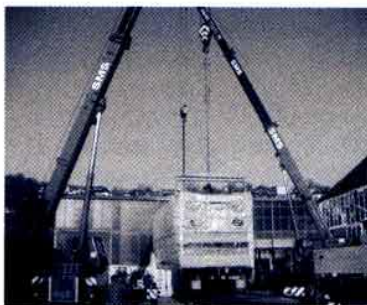
Abb. 1: Abladen des dreistöckigen Hauptwaschabteils
